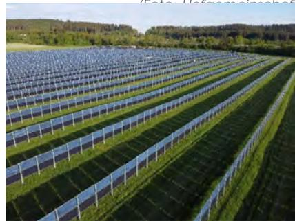
Abbildung 2: vertikal montierte, nach Ost-West ausgerichtete PV-Reihen bei Donau- eschingen (Foto: Next2Sun GmbH)
